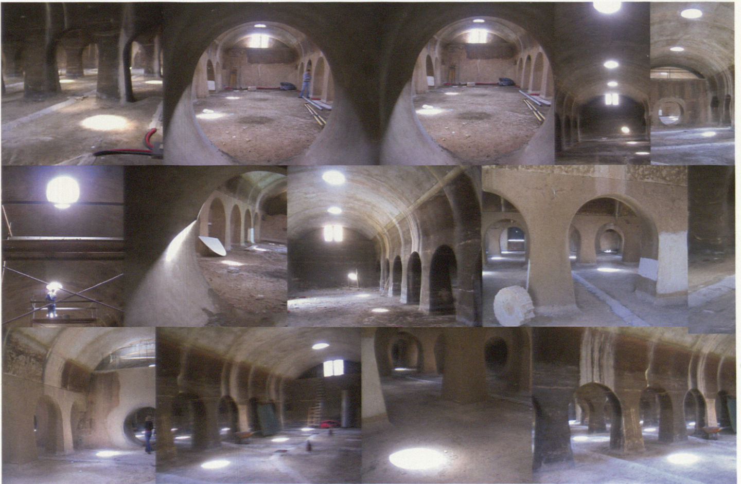
Aparición de los óculos en las bóvedas durante la obra. The vaults' holes appearing during the building work.
